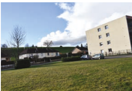
Depuis la démolition de la tour rue du Port Mahon, le site était resté en l'état.
