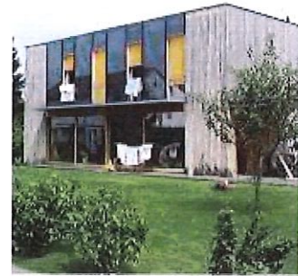
Les capteurs posés verticalement participent pleinement de la composition de la façade. Maison individuelle à Wulfurt (Vorarlberg, Autriche) © CAUE 78
