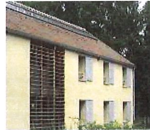
Un ensemble de capteurs thermiques s'aligne à l'aplomb de la toiture. Centre météorologique de Bulhon (Yvelines), Cabinet M'André architectes © PNR Haute Vallée de Chevreuse
