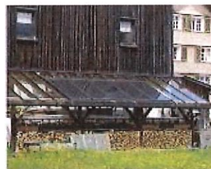
Les capteurs sont intégrés à la couverture d'une remise à bois. Maison individuelle (Varemborg, Ardèche) © PNR du Vexin français
