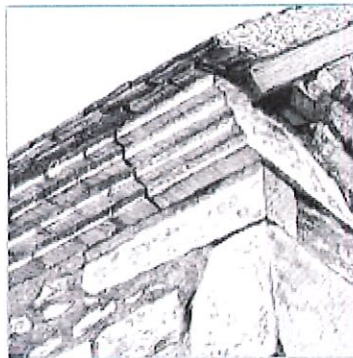
Détail de corniche en brique
