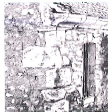
Raccordement d'une corniche en pierre sur une chaîne d'angle
