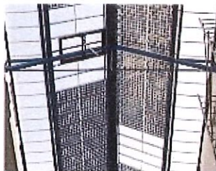
Les capteurs photovoltaïques sont intégrés à la verrière de la galerie de distribution d'une résidence HLM. L'Isle d'Azeau (Isère) © Photowatt
