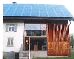
Un ensemble de capteurs recouvre toute la surface du toit, comme une nouvelle couverture. Crèche à Zweisimmen (Vorarlberg, Autriche) © CAUE 78
