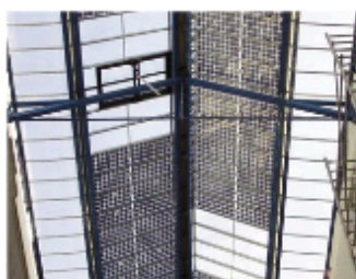
Les capteurs photovoltaïques sont intégrés à la verrière de la galerie de distribution d'une résidence HLM. L'Isle d'Abau (Isère) © Photowatt
