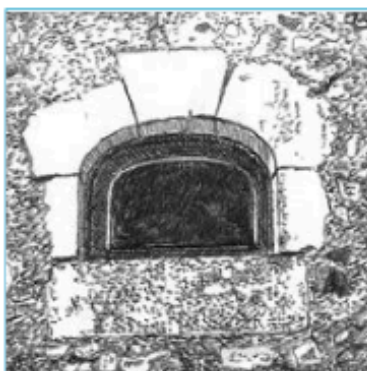
Détail d'une ouverture en pignon
