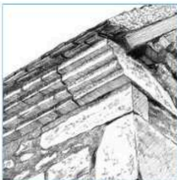
Détail de corniche en brique
