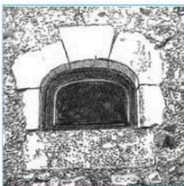
Détail d'une ouverture en pignon
