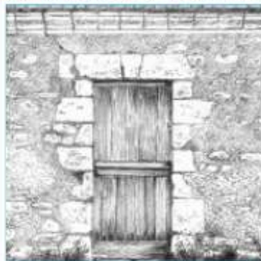
Détail de porte de ferme
