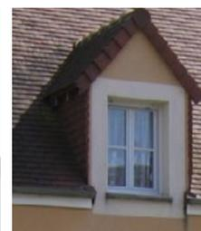
La tuile de rive avec un rabat aura tendance à alourdir les lignes sur les rives de toit, ou recouvrir la lucarne. Les maisons du Perche ont des toitures importantes, il est conseillé de travailler les éléments de toiture de façon simple, sans surcharge.
