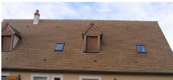
Un nombre trop important de lucarnes a tendance à alourdir la construction et à compliquer le recueil des eaux de pluie. Mieux vaut compléter avec des châssis de toit sur un autre versant de toiture.
