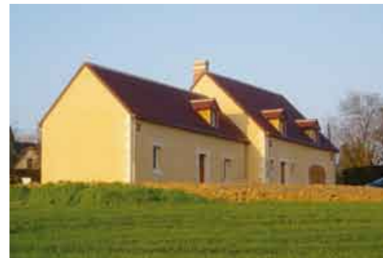
Volume simple avec une pente de toit supérieure à 45° qui affine la silhouette de la maison et rappelle les maisons anciennes.
