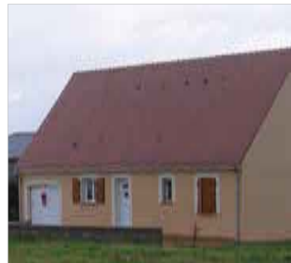
Les volumes en long de cette construction neuve rappellent parfaitement la maison rurale percheronne.
