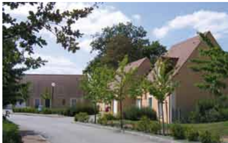
Nouveau quartier dans le Perche. La voirie à double sens ici a été volontairement réduite à une largeur de 5 mètres. Elle s'accompagne d'un cheminement piétonnier distinct, stabilisé en sable et séparé par un petit terre-plein végétalisé.
