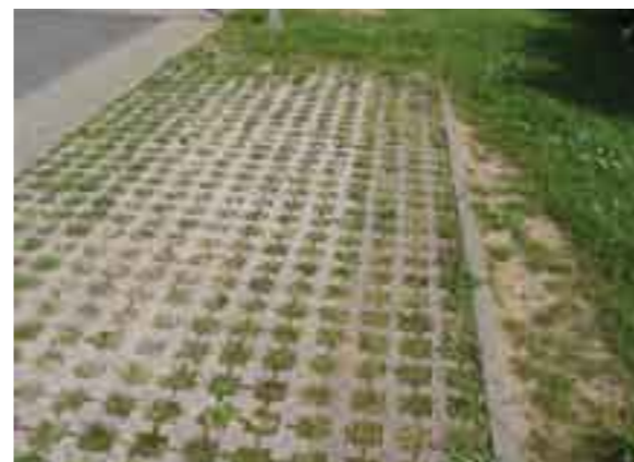
Traitement du revêtement des parkings par dalles engazonnées qui permettent l'infiltration douce de l'eau de pluie et offrent un aspect moins rigide que de nombreux revêtements couvrants.
