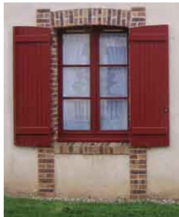
- Fenêtre neuve dont l'encadrement et les jambages en brique imitent le traitement traditionnel des baies du nord du Perche. Les vitres, sur les bâtiments traditionnels, sont au nombre de 3 ou 4 par vantail.
