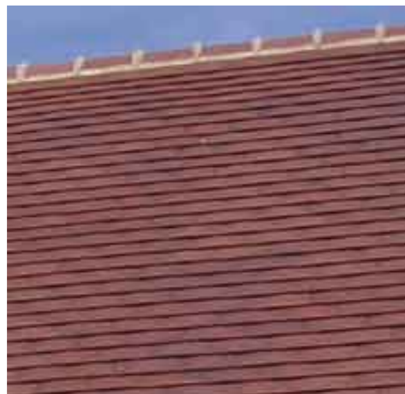
Couverture neuve aux teintes nuancées qui imite la tuile petit moule sans en avoir cependant la densité.
