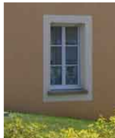
- Simplement lissé et badigeonné de blanc, l'encadrement de cette fenêtre donne davantage de relief au mur et en éclaire la surface.
