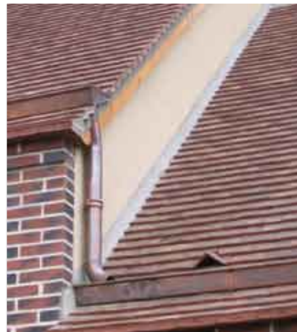
Détail d'une couverture neuve de type traditionnel.
