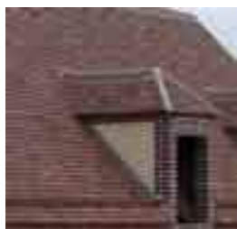
Lucarne neuve au-dessus de l'égout avec toit à croupe et traitement des jambages en brique.
